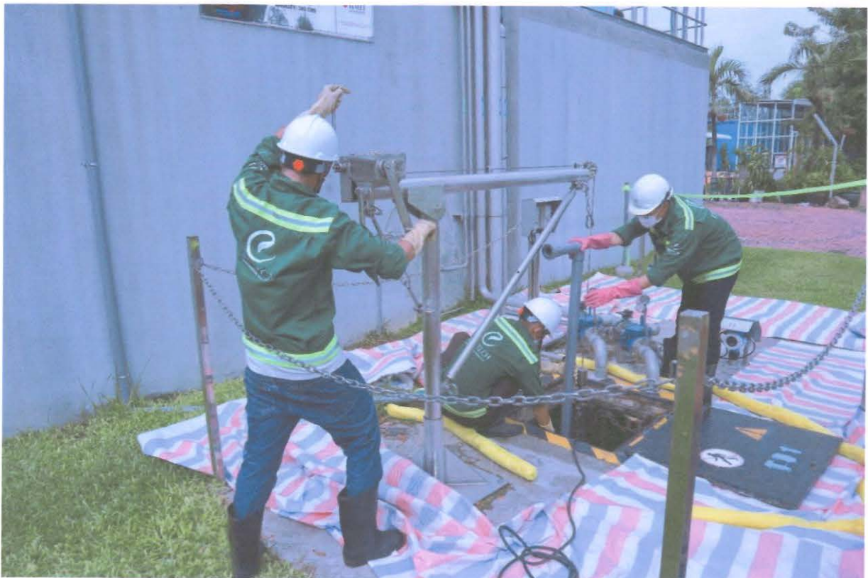
Hình 11: Đội UPSC thiết lập bơm dự phòng vận chuyển nước thải về bể điều hòa, tránh nước thải chảy tràn bể tiếp nhận. Đồng thời, đưa bơm hỏng lên và tiến hành vệ sinh/bảo trì.
