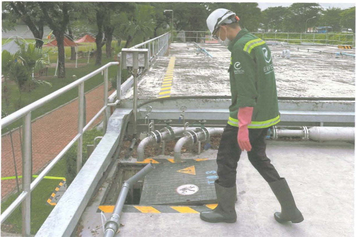
Hình 12: Đội UPSC kết nối đường ống và dẫn nước thải về bể điều hòa.
