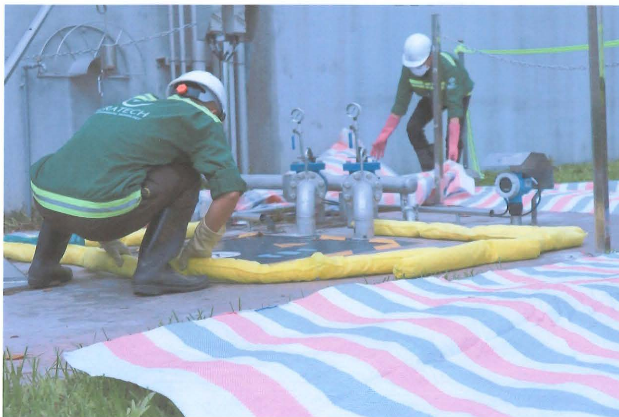
Hình 10: Đội UPSC trải tấm bạt chống thấm, dùng các phao vây vây xung quanh để đề phòng trường hợp bể tiếp nhận nước thải vượt tải chảy tràn ra bên ngoài ảnh hưởng đến môi trường xung quanh.
