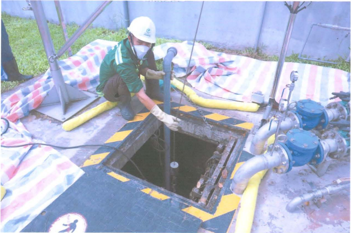
Hình 13: Sau khi bơm hỏng được vệ sinh/bảo trì xong được thả lại đúng vị trí ban đầu và tiếp tục cho hệ thống vận hành lại bình thường.
